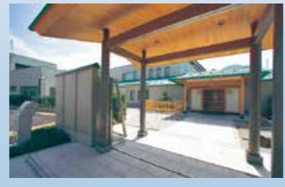
⑲愛媛（四国第一）偉光会館／松山市
